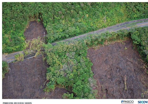
図7 高精密な斜め写真画像② (上流御神火スライライン付近)
