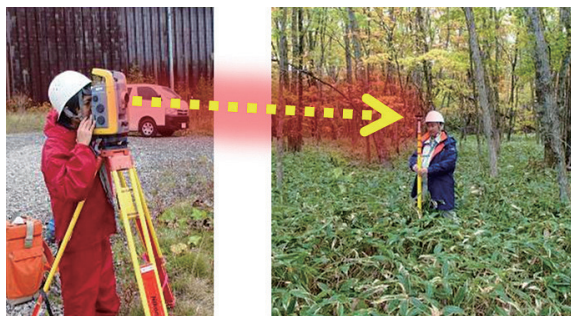
図 20 樹木下の実測状況
