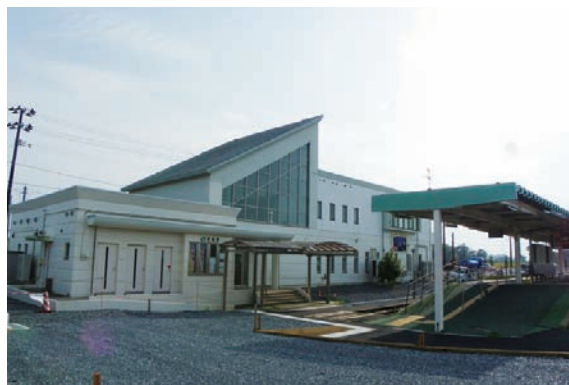
写真3 修復工事中の旧野蒜駅舎とプラットフォーム(2016年撮影)
