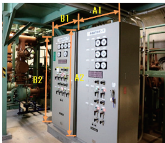
図6 寸法検証(鋼巻尺)
