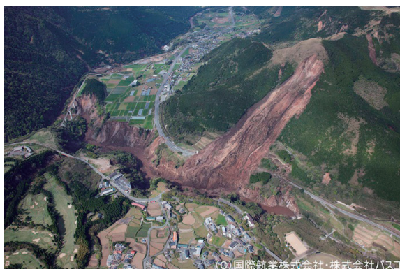
図8 阿蘇大橋西方の山地斜面で発生した斜面崩壊
