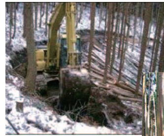
路網（作業道）の整備
