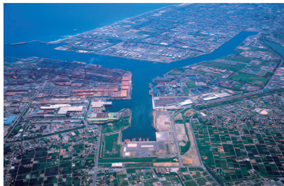
図4 鹿島港【提供：（財）港湾空間高度化環境研究センター】
