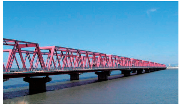
図21 木曽川大橋のトラス斜材の破断事故 【出典：国土交通省 「道路橋の予防保全に向けた有識者会議」資料】
