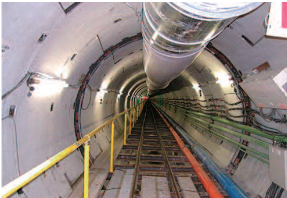
(c) 石岡トンネル
