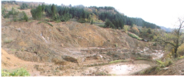
〈法師ヶ沢川崩壊状況2〉
