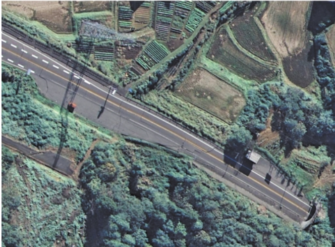
図. 2 国道17号（小千谷市津山地区）
