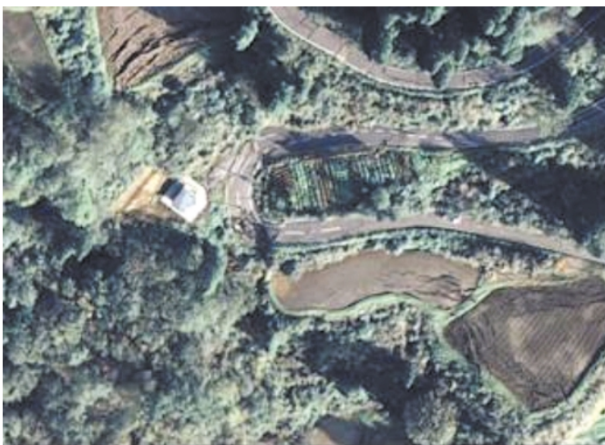
図. 3 東竹沢の北側斜面（拡大） （幅数10mの亀裂が判読できる）
