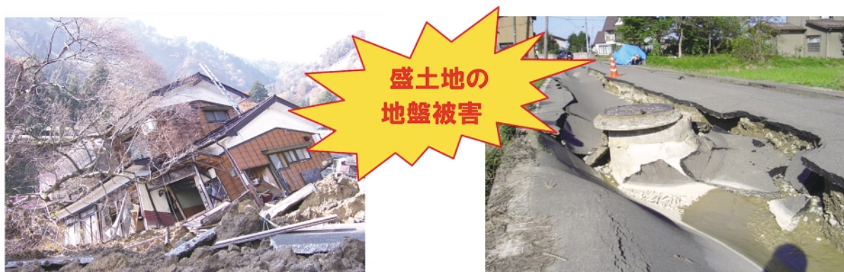
図1 造成盛土の被害
