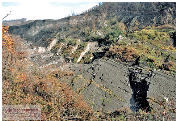
写真2 傾動変形した国道230号（2000年11月2日千葉撮影、位置は図3に示す）写真左側が北方向で、潜在ドームの隆起中心のある方向
