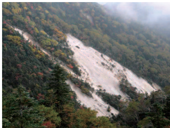
図4.5 近赤外レーザが強い反射を示す崩壊地（栃木県日光市・稲荷川流域最上流部）
